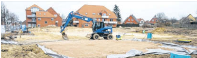
Im Meinsdorfer Weg 27 fiel gestern der offizielle Startschuss für die Errichtung von 17 barrierefreien Wohnungen.
